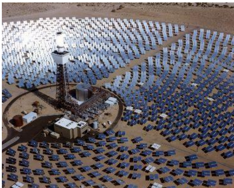
Рисунок 6. – Солнечная электростанция башенного типа с коллекторами-концентраторами
