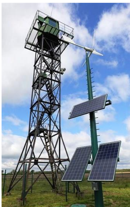
Рисунок 3. – АПТН, оснащенный поликристаллическими солнечными фотопанелями и ветрогенератором
